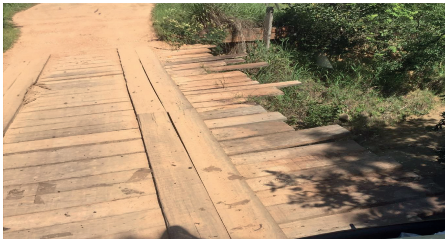
Figura 26 - Ponte de madeira, estrada de chão entre os municípios de Paranã e Arraias
