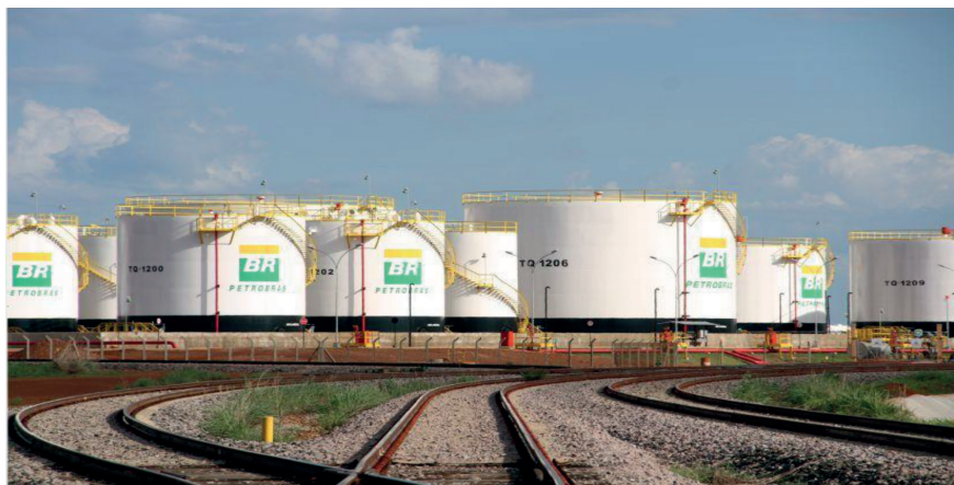
Figura 9 - Construção da Distribuidora Petrobrás no pátio multimodal da ferrovia Norte-Sul em Luzimangues, distrito de Porto Nacional
